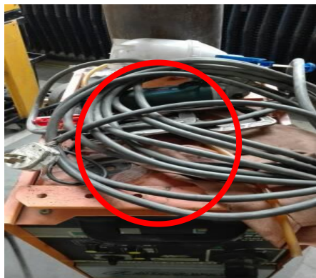
6.电焊机一次线长度超过3米
